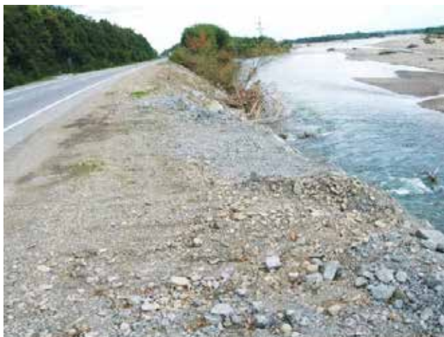
Рис. 7. Розмив високого терасового лівого берега р. Стрий за рахунок розвитку крупної звивини біля шосе Львів – Чоп (с. Гірне)
