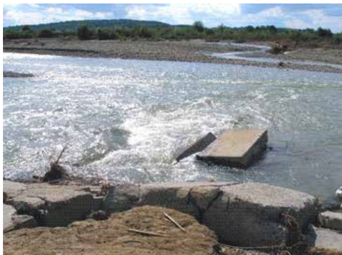
Рис. 10. Розмив шпори на р. Бистриця Надвірнянська біля с. Цуцилів
