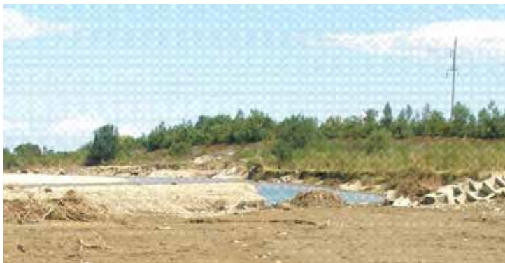
Рис. 9. Розмив дамби обвалування на правому березі р. Бистриця Надвірнянська вище с. Черніїв (На другому плані видно більш потужну дамбу обвалування ставка)
