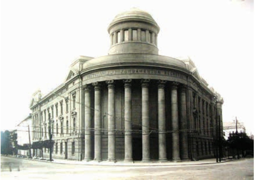
Палата правосуддя та Сейм Литовської Республіки останнього міжвоєнного скликання. У цій будівлі в Каунасі було ухвалено Конституцію Литви 1938 р. 7
